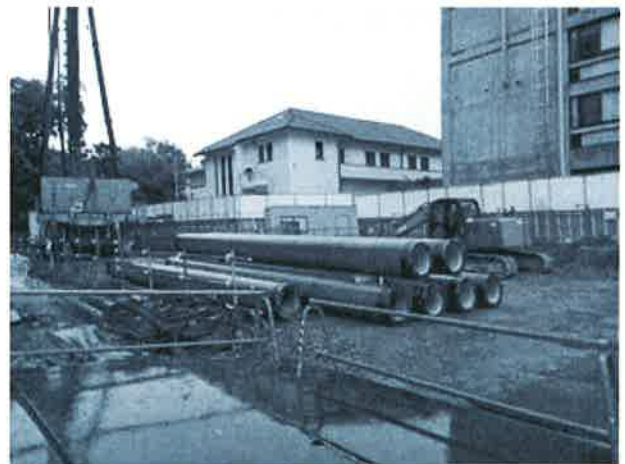
建設現場(2014年5月)東南方向に撮影
